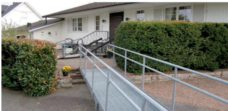
Gambar 8.1: Jalan atau Jembatan untuk Berjalan
